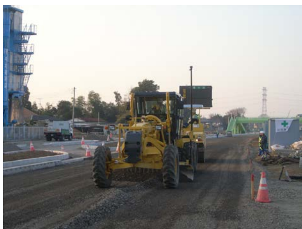
図-7 3D-MCを搭載したモータグレーダ
