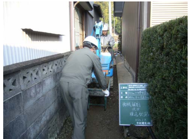
写真-1 掘削運搬状況
