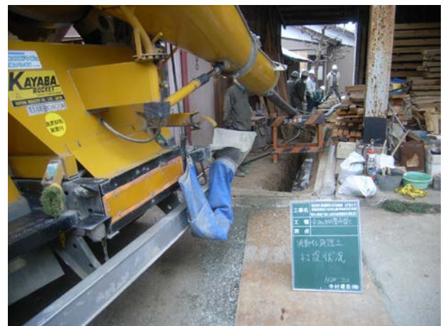
写真-2 流動化処理土による埋戻し状況
