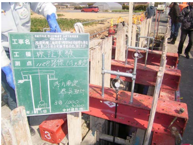
写真-3 浮力測定状況
