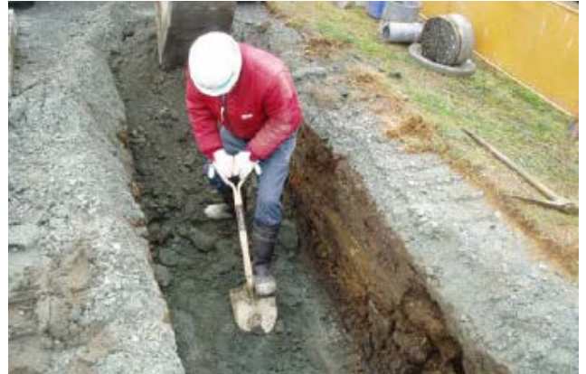
写真-7 人力による二次掘削
