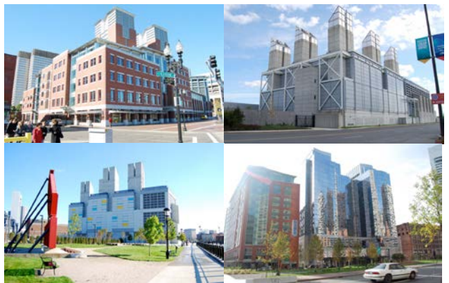
写真-5 海外事例の例（Boston BIGDIG換気塔群）
