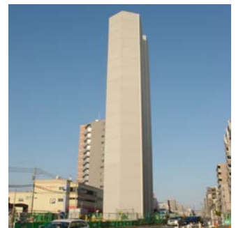
写真-3 主張的な見せ方の換気塔事例（中落合換気所）
