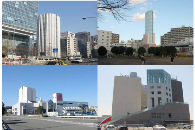
写真-4 国内事例の例（左上から右回りに鍛冶橋換気所、北町若木換気所、入船みなと換気所、並木換気所）
