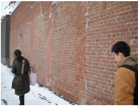
写真-4 補強後外観を復元した家屋外壁
