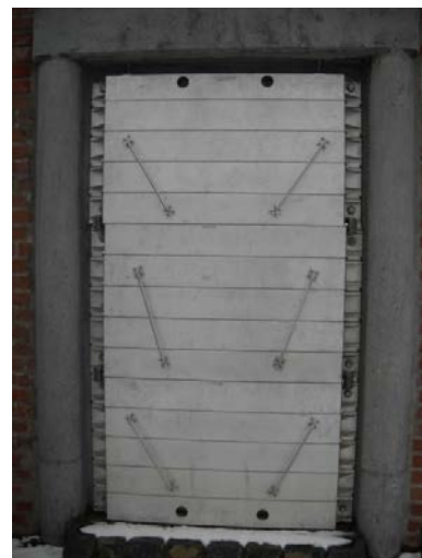
写真-6 横矢板式防水板の例
