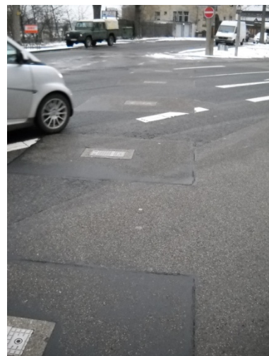
写真-7 道路上に設けられた支柱基礎
