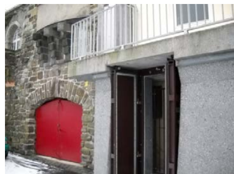
写真-3 防水扉を併設する出入口
