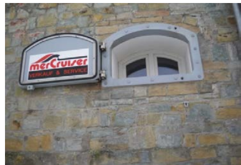
写真-2 窓に防水扉を設けた家屋壁面
