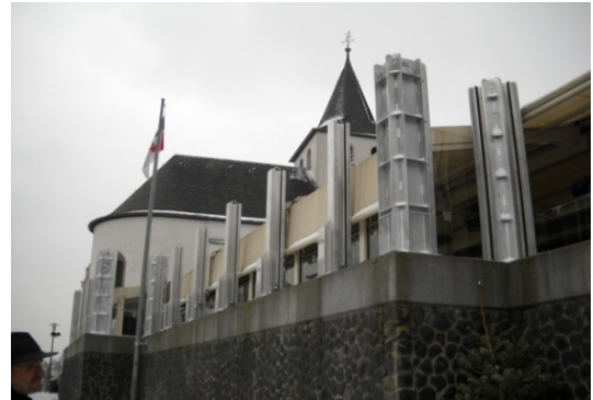
写真-5 平常時から設置されている堤防支柱
