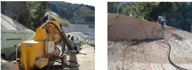
図-2 湿式吹付け機と吹付け作業状況
