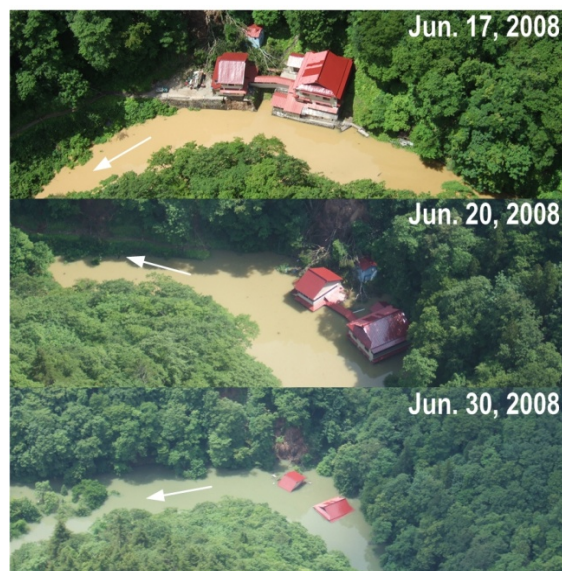
写真-2 家屋がせき止められた水に浸かった例 (湯ノ倉温泉付近)
