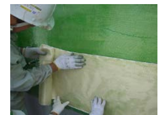
写真-12 アラミド繊維貼付状況
