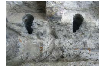
写真-8 堰柱部鉄筋位置の確認状況
