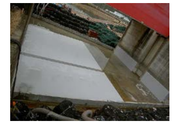
写真-10 完成 (ATモルタル被覆)
