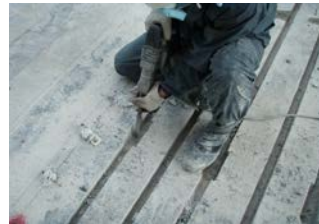
写真-5 底板部の溝掘状況
