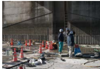
写真-7 堰柱部の溝掘状況
