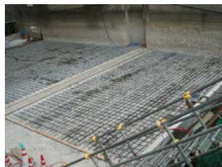
写真-9 底板部の配筋完了
