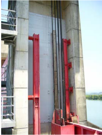
写真-13 完成 (アラミド繊維貼付)
