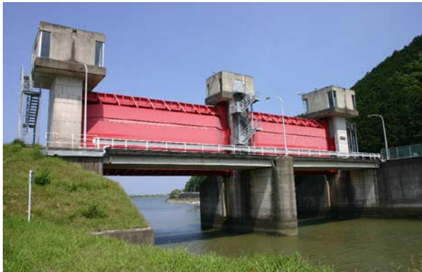
写真-1 津蔵測水門
