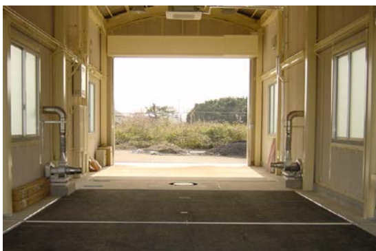
写真-3 FWD検定施設の内部
