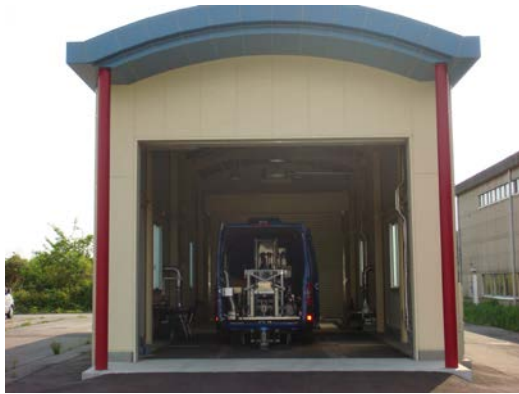
写真-2 土木研究所に設置した「FWD検定施設」
