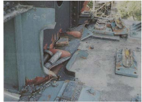
写真-2 S42桁の状況 3), 4)
