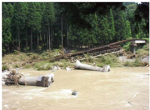
写真-2 JR鉄橋の流失
