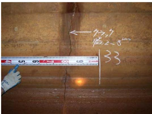
写真-2 函体の損傷状況(スパン3)
