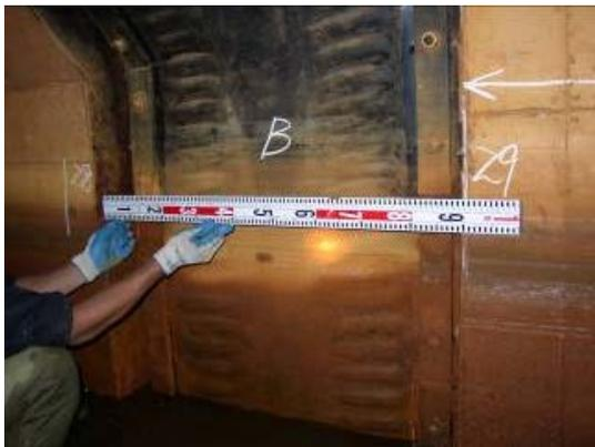
写真-1 函渠の継手の開き(継手 B)
