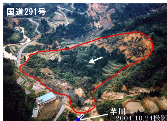
写真-1 東竹沢地区河道閉塞の状況
