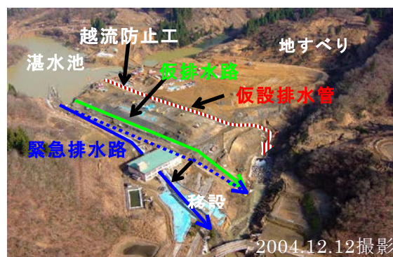
写真-3 東竹沢地区河道閉塞での緊急対策状況
