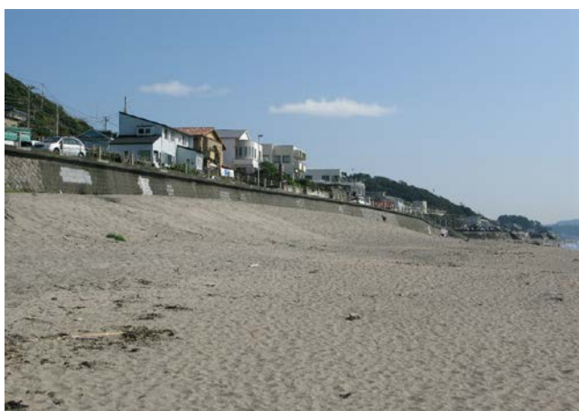
写真-4 隅角部のA付近の海浜状況
