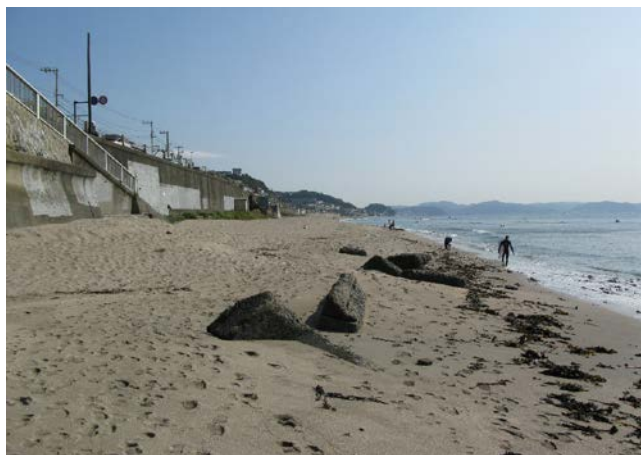
写真-3 階段付近の海岸状況
