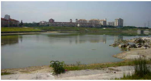
図-7 クアラルンプールの遊水地（建設中）
