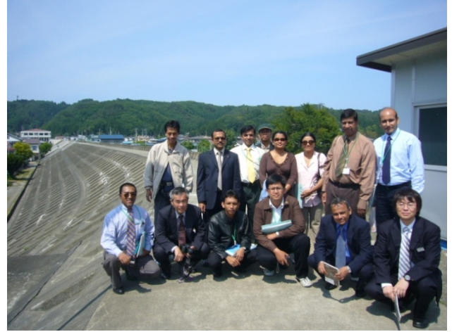
写真-3 三陸地方への現地見学の様子（岩手県宮古市田老地区の津波防波堤）
