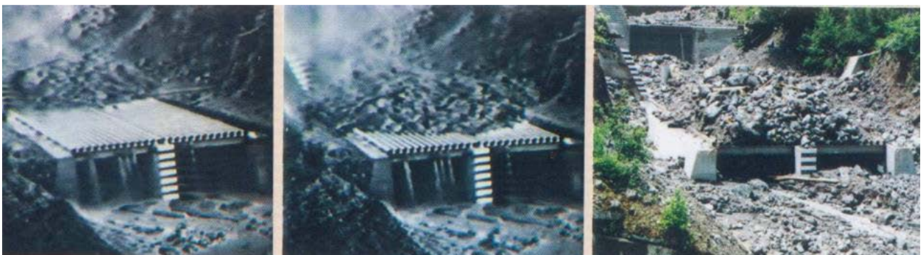
写真-1 焼岳での土石流停止写真（松本砂防工事事務所撮影、昭和60年7月21日出水）
