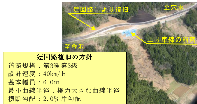
図-7 迂回路による応急復旧
