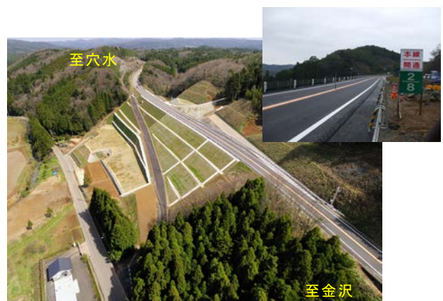
図-15 本線復旧完成状況 (縦-9)
