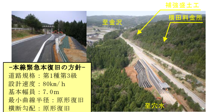
図-9 本復旧断面の急速施工
