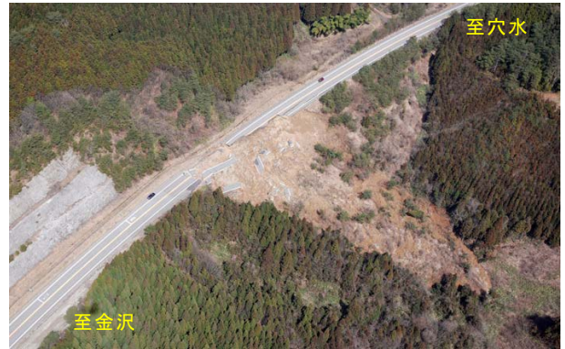
図-2 大規模崩壊全景
