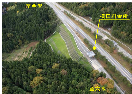
図-14 本線復旧完成状況 (縦-10)
