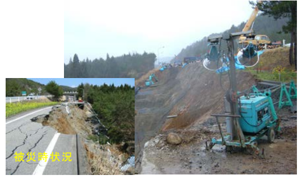
図-8 横田ONランプ突貫工事
