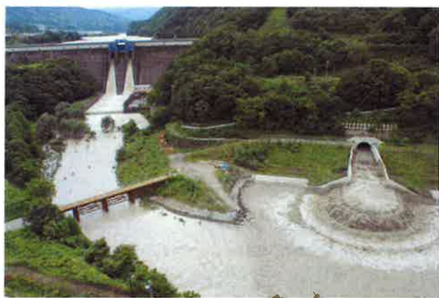
写真-1 美和ダムと三峰川バイパス出口 (平成19年9月7日試験運用時撮影)
