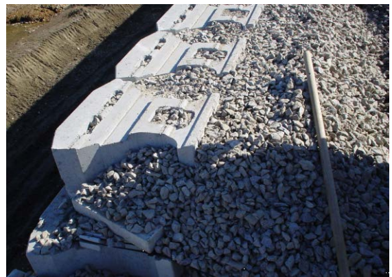
写真-4 ブロック形式の壁面工
