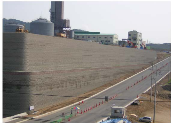
写真-3 大規模補強土壁の施工過程
