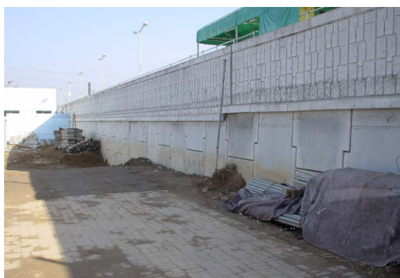
写真-6 補強土壁（ウェルソブ工法）
