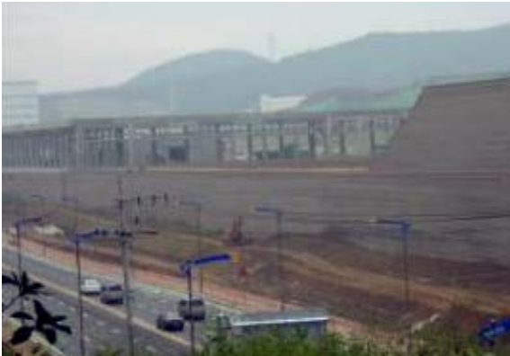
写真-2 道路橋を背負う大規模補強土壁
