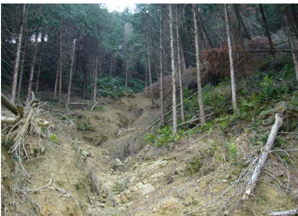
写真-2 新居浜地区で発生した表層崩壊の様子
