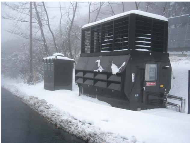
写真-2 ヒートポンプの設置状況
