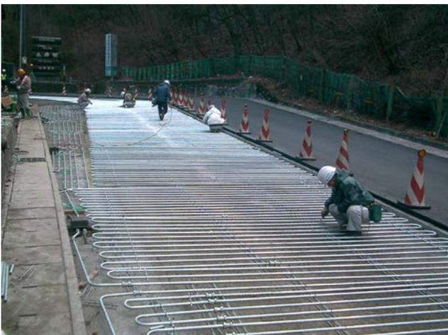
写真-3 放熱管の布設状況
