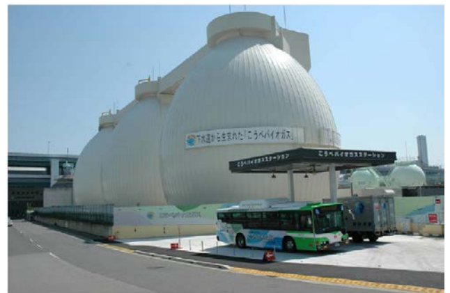
写真-3 こうべバイオガスステーション
