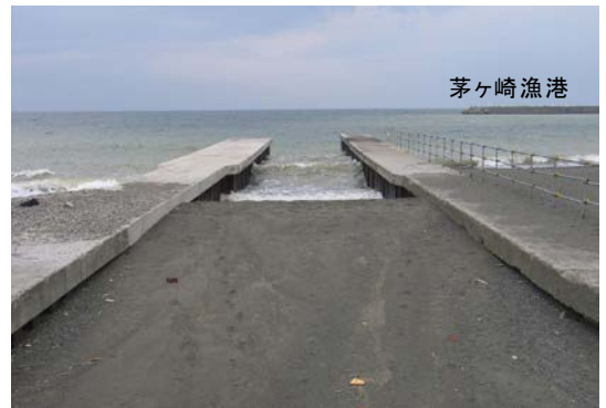
写真-2 茅ヶ崎中海岸の西端にある海水浴場との境界に伸びた6号水路の導流堤
