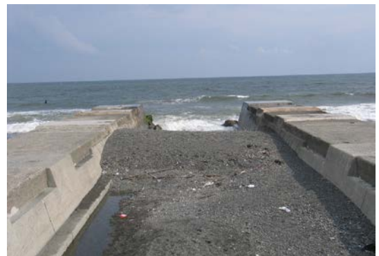
写真-1 湘南海岸の3号水路の出口にある導流堤
