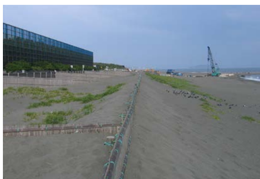
写真-4 堆砂垣を超えて裏側に大量に入り込んだ飛砂
