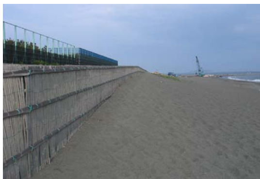
写真-3 茅ヶ崎ヘッドランドの背後地における堆砂垣前面での飛砂の堆積状況
