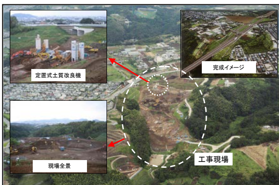
図-6 伊豆縦貫道-塚原IC工事の様子
