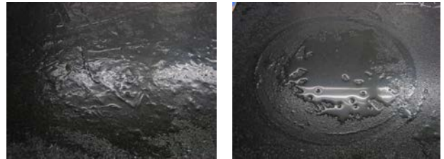
写真-4 路面状態（左：測定前，右：3回の測定後）
