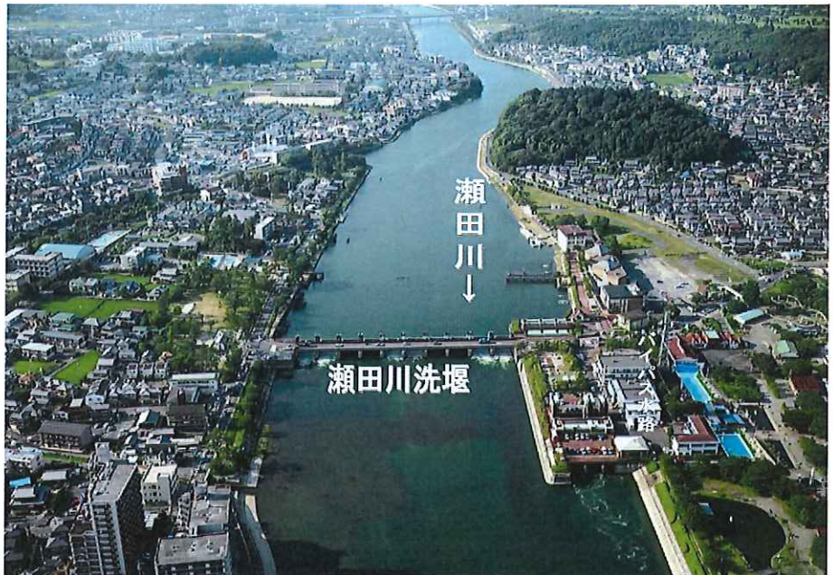
写真-1 瀬田川洗堰の全景
