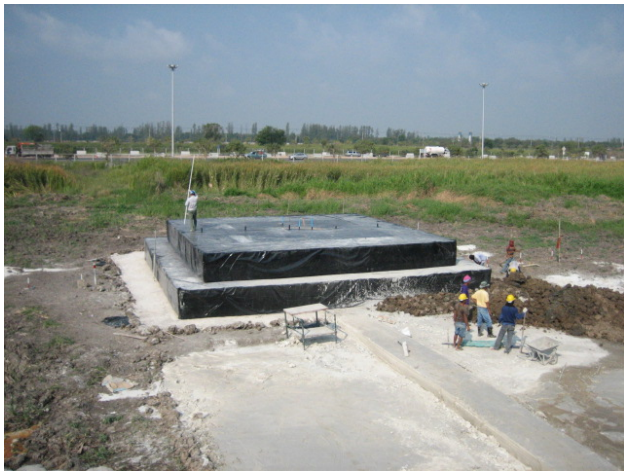
写真-1 気泡混合土の打設終了時
