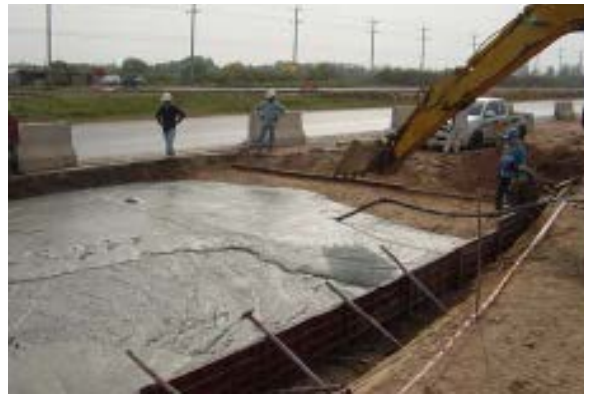
写真-6 気泡混合土最終打設状況
