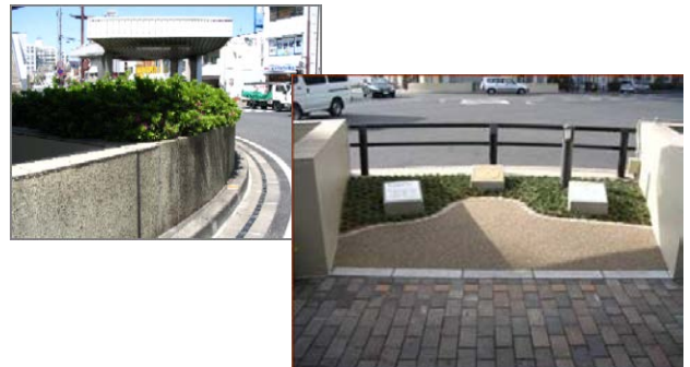
図-8 壁面改修、植栽撤去（左：改修前、右：改修後）
