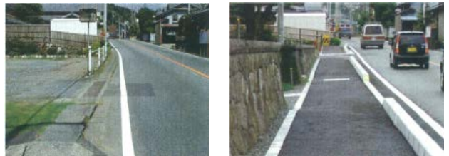
図-15 歩道整備状況（左：整備前、右：整備後）
