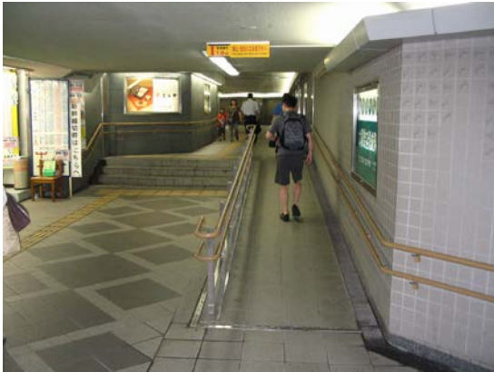
図-10 地下道のリニューアル
