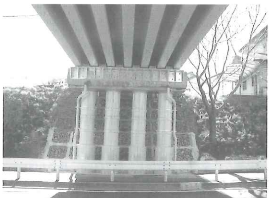
写真-5 (2) 補強後 (橋軸直角方向)
