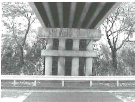
写真-2 現況 (橋軸直角方向)
