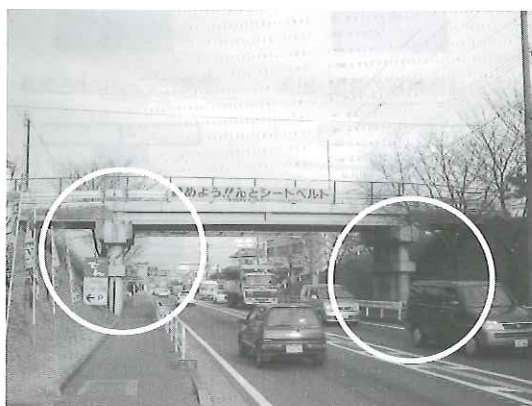
写真-1 現況 (橋軸方向)
