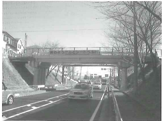
写真-5 (1) 補強後 (橋軸方向)
