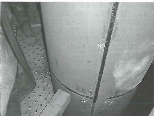
写真-4 (2) 補強鋼板溶接完了
