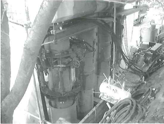
写真-3 圧入装置設置状況
