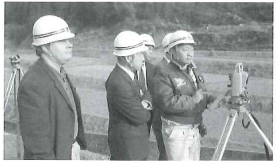
写真-2 高知県における実証実験風景
