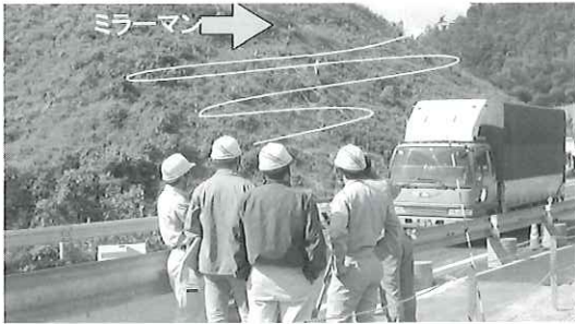
写真-1 現地地形の計測状況（ミラーマン：TSによる計測で日標となる反射鏡をもって移動する人）
