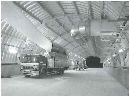
写真-1 実験棟内部
