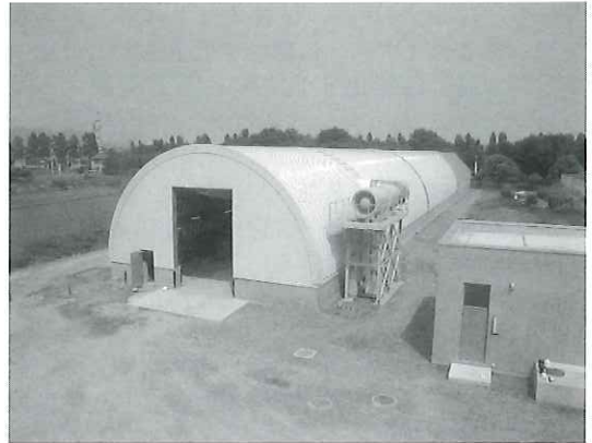
写真-2 実験棟外観と送風機
