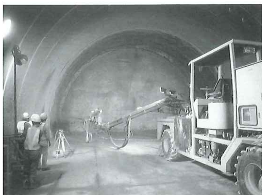
写真-5 エアレス吹付け機
