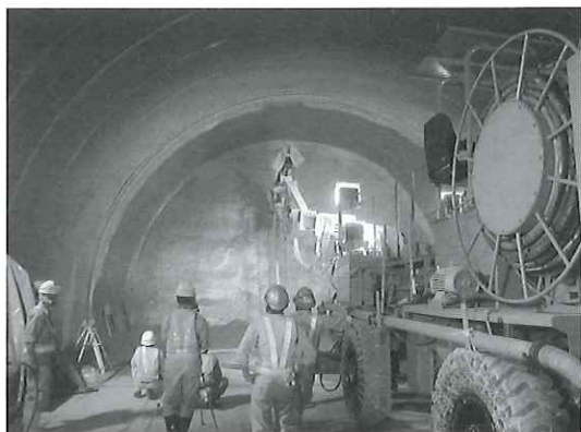
写真-6 ダストレスの吹付け機
