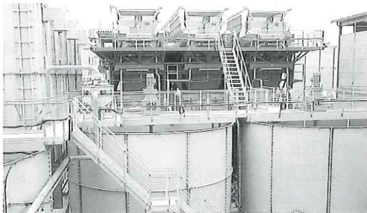
写真-2 埼玉高速鉄道線 大門トンネル工事
