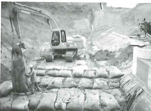
写真-10 施工中の状況
