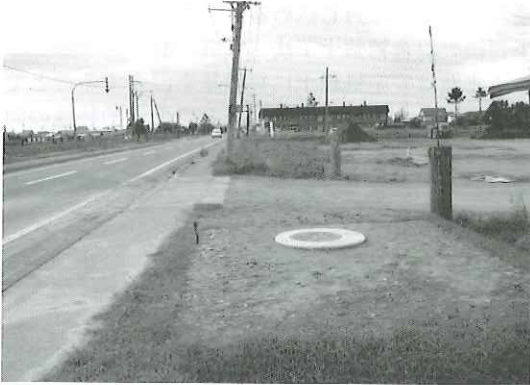
写真-6 施工後の状況 (十勝地震後)
