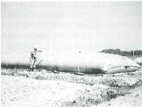
写真-3 袋詰脱水処理工法
