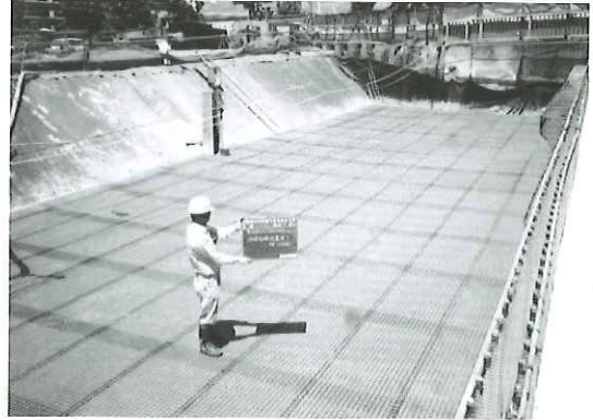
写真-7 施工後の状況
