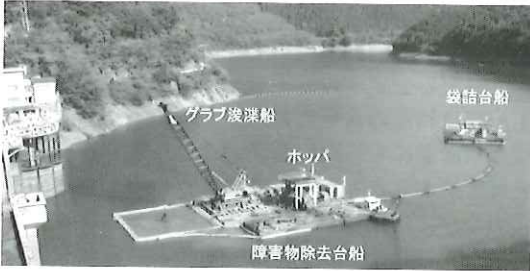
写真-9 施工中の状況
