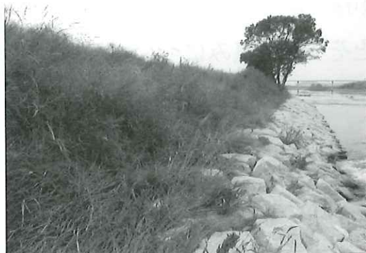
写真-11 施工後の状況
