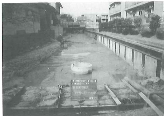
写真-8 施工後の状況
