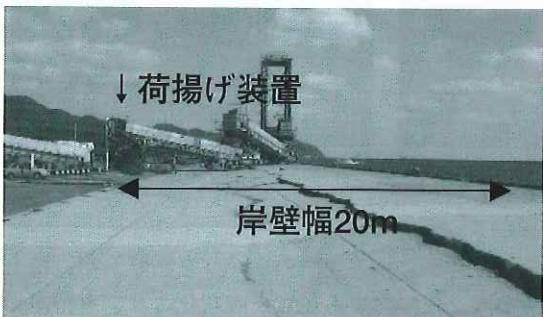
図-10 岸壁に生じた段差の状況
