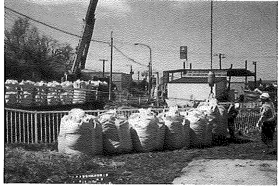
写真-5 大型土のうの設置状況 (2000 年 4 月 26 日撮影) してある。
