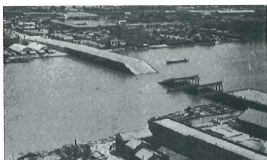
写真-1 新潟地震による昭和大橋の落橋
