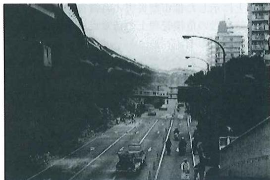
写真-3 兵庫県南部地震による高架道路の倒壊
