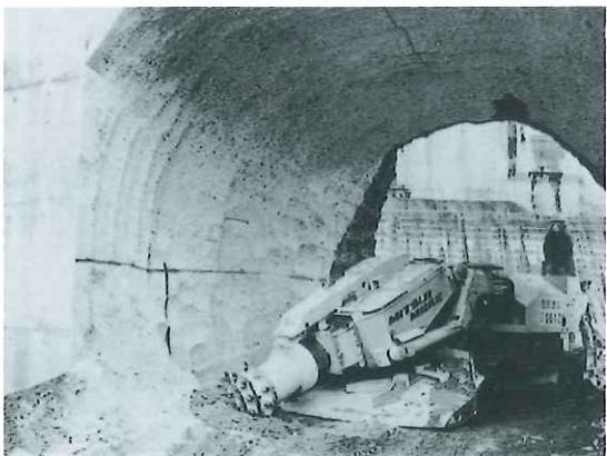
ムに空洞を設ける場合には、鉄筋による補強は不可能である。このため、空洞を開けることにより既設堤体に悪影響を及ぼさないか、事前に応力解析を行い確認しておく必要がある。
