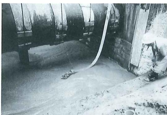
写真-1 流動化処理土による管の埋戻し
