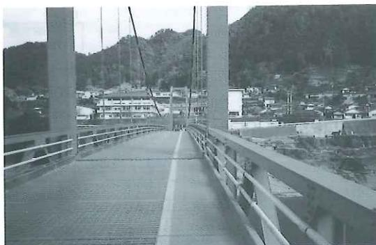
写真-5 萩生川橋 (橋面の全景：左側がオープニングレーティング)
