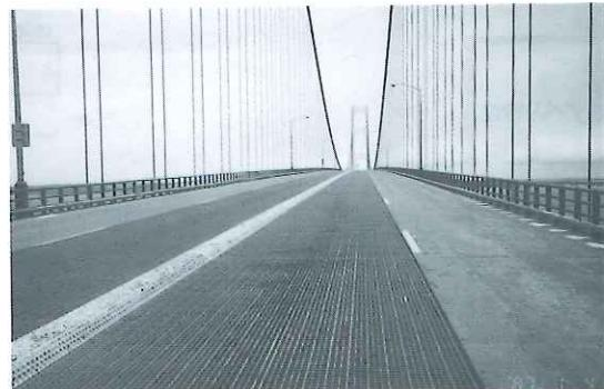
写真-7 マキノ橋 (橋面の全景：中央二車線がオープニングレーティング)
