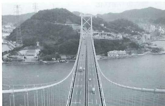
写真-1 関門橋(橋面の全景：中央分離帯と路側にオープニングレーチングが設置)
