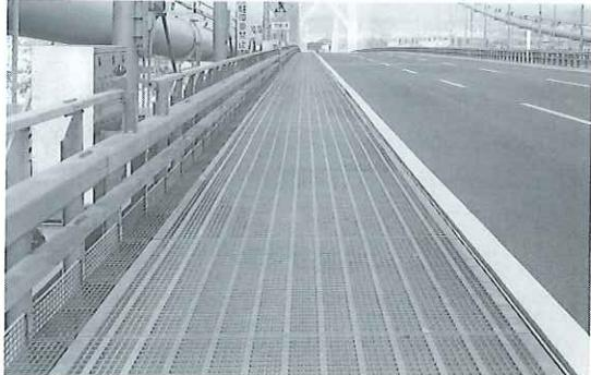
写真-3 明石海峡大橋 (橋面の全景: 中央分離帯と路側にオープンデッキ床版が設置)
