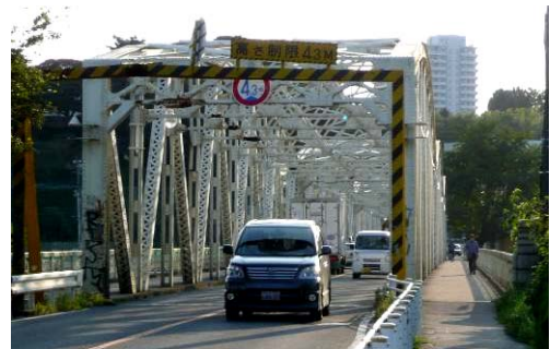
写真-9 水府橋外観
