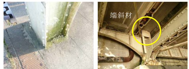
写真-10(1) 埋設部状況 (端斜材)
