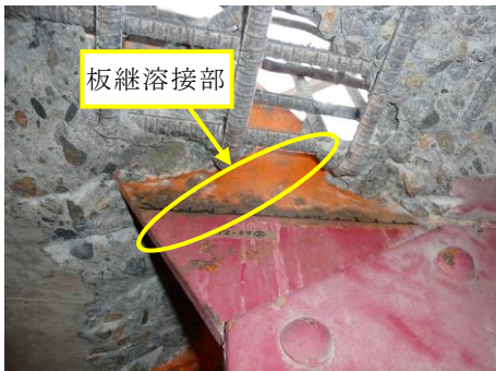
写真-3(2) 埋設部材の外観（床版下面）
