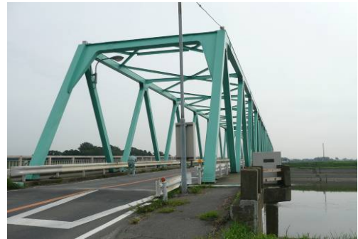
写真-5 高須橋外観
