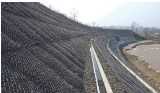
写真-1 特殊ふとんかご工法の施工例
