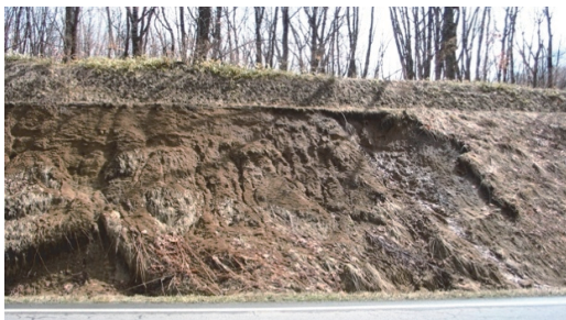
写真-2 凍結融解による斜面の崩壊
