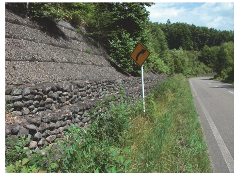
写真-6 かご布設後20年経過後ののり面
