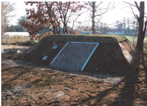
写真-4 試験盛土の全景
