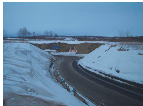
写真-3 冬季試験現場全景
