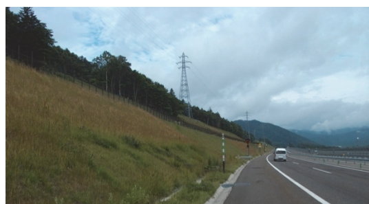
写真-7 二重張芝による緑化（施工後5年経過）
