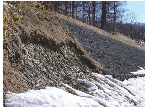
写真-5 未施工区ののり面
