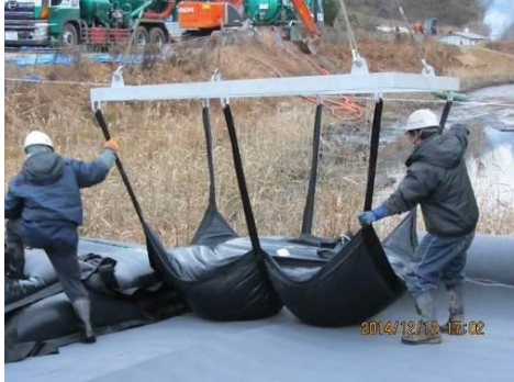
写真-5 移設状況
