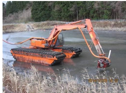
写真-2 泥上掘削機による掘削
