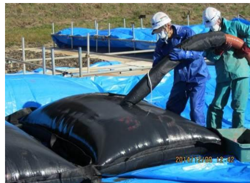
写真-4 充填の状況
