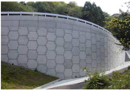
図-1 補強土壁の例(テールアルメ工法)
