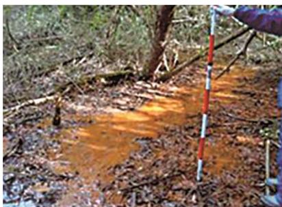
写真-2 盛土法尻部の湧水例
