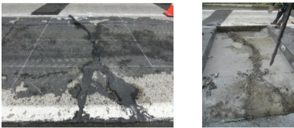
【開削前の路面状況】 【開削後の舗装下面の状況】
