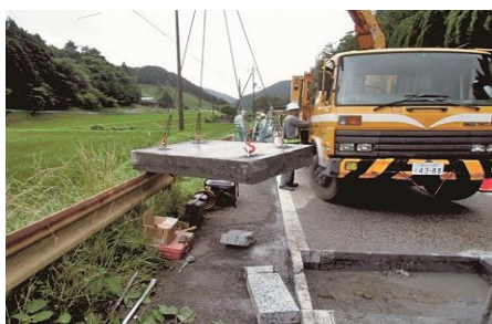
写真-3 正常目地部（膨張目地）部
