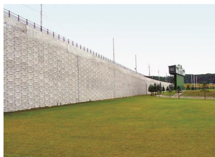
写真・2 多数アンカー工法
