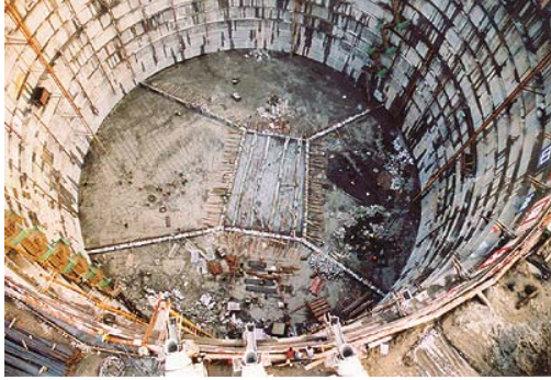
写真-6 長江大橋の立坑（連壁内径70m、深さ60m）
