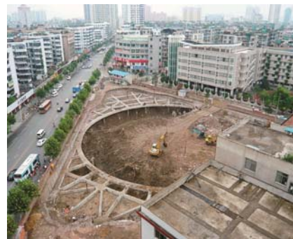
写真-5 柱列式連続壁+切梁（深さ10.5m、面積5千㎡）
