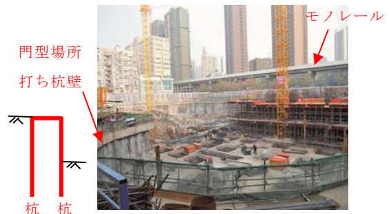
写真-4 門型柱列式連続壁（深さ11m、面積1.1万㎡）
