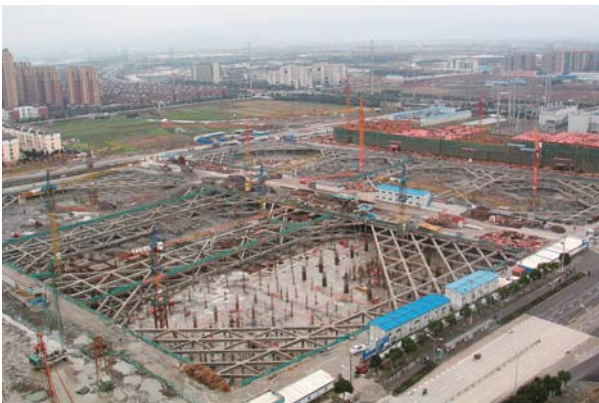
写真-7 20個立坑群の一部（地下2階、総面積35万㎡）
