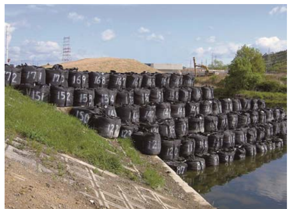
(b)「耐候性大型土のう」
