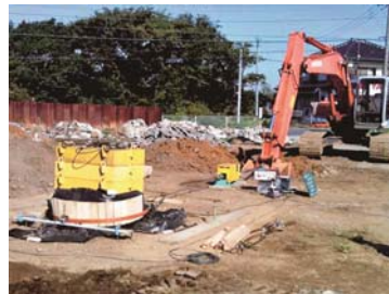
写真-4 実大摩擦特性確認試験
