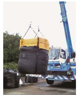
写真-5 吊上げ・吊下ろし特性性能試験
