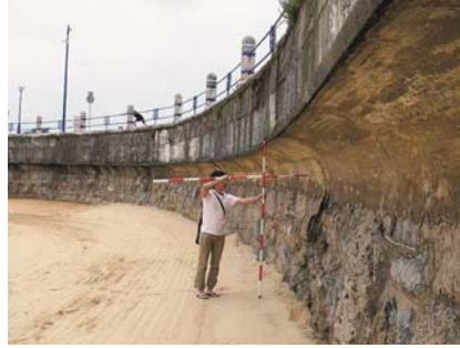
写真-5 護岸中央部のパラペット (波返し) と海側に突出した護岸上部
