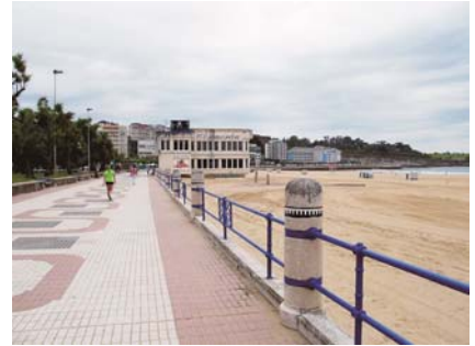
写真-11 石積み護岸上の遊歩道と柵の構造
