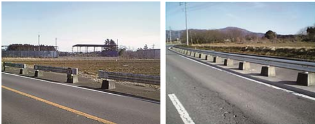
単独設置 ビーム連結設置 写真-4 独立基礎タイプ仮設柵
