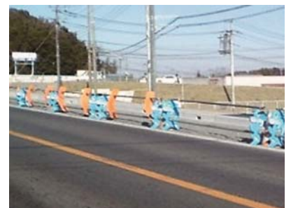
写真-3 工専用バリケードの設置例
