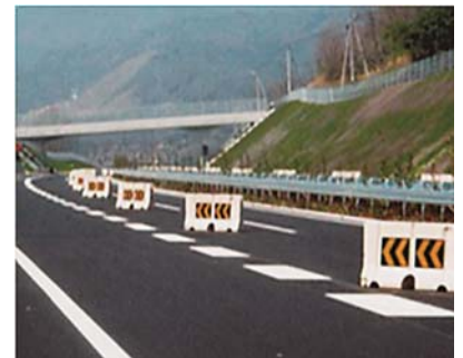
写真-7 壁ブロックの単独設置例 2)
