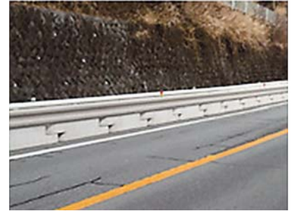
写真-6 ガードレールタイプ仮設車両用防護柵の例 1)
